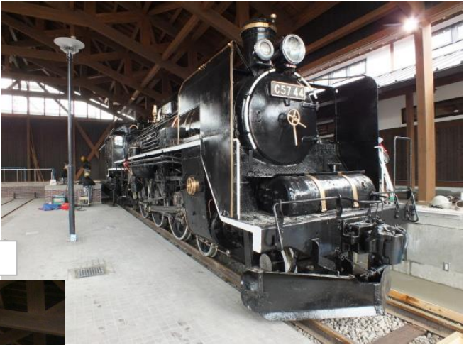
四国鉄道文化館 南館 据え付け時(H26.2.28)
