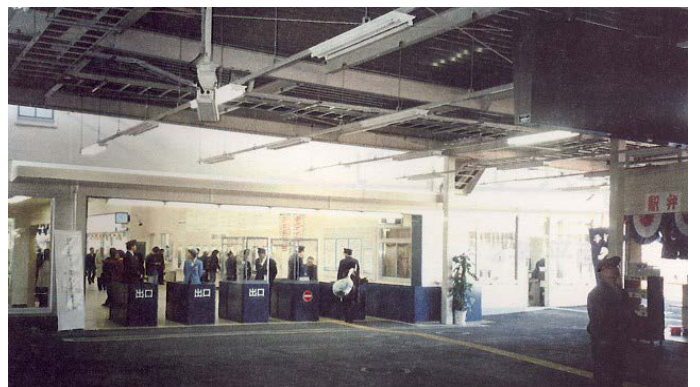
平成9年12月 仮駅舎出改札
