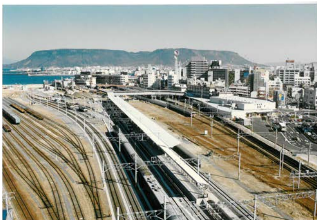
平成9年12月 仮駅舎へ移転
