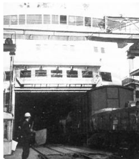
船舶への貨物押し込み作業
