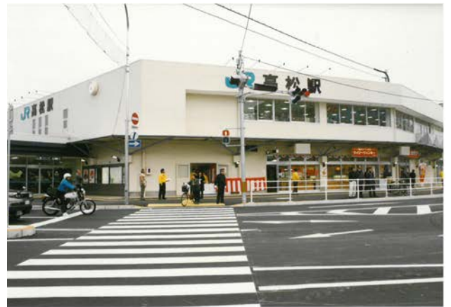
平成9年12月20日 仮駅舎営業開始
