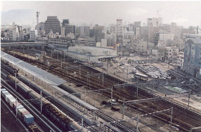
新ホーム建設
