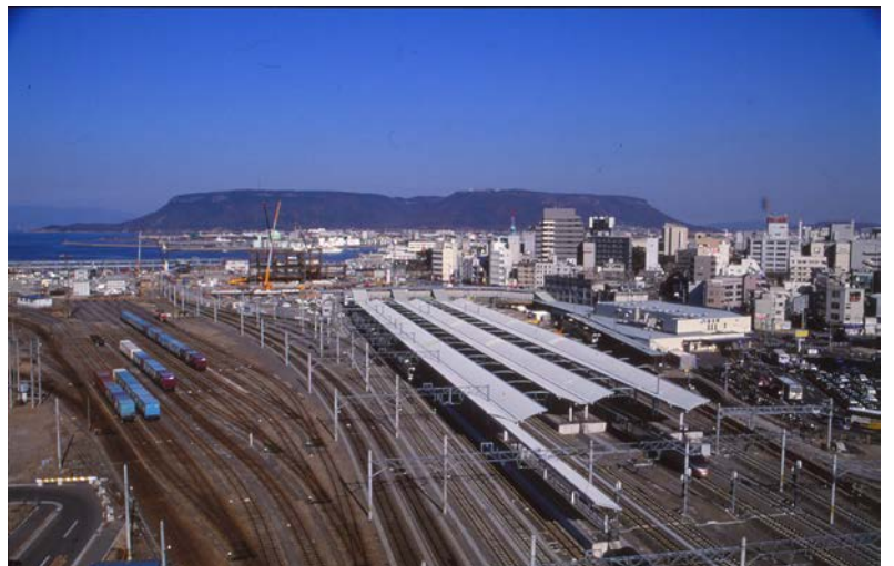
サンポート高松に「クレメントホテル」建設中
