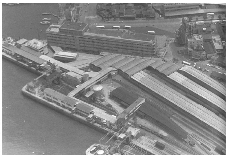
昭和34年9月 完成した3代目高松駅
