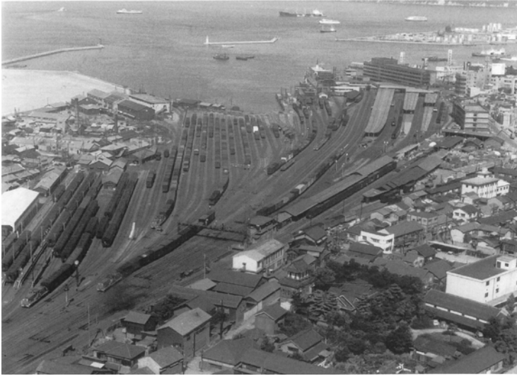
昭和42年 高松駅構内
